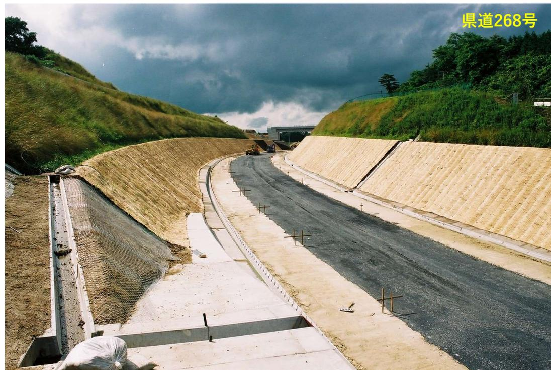
1段目の施工完了（わらむしろによる養生）
